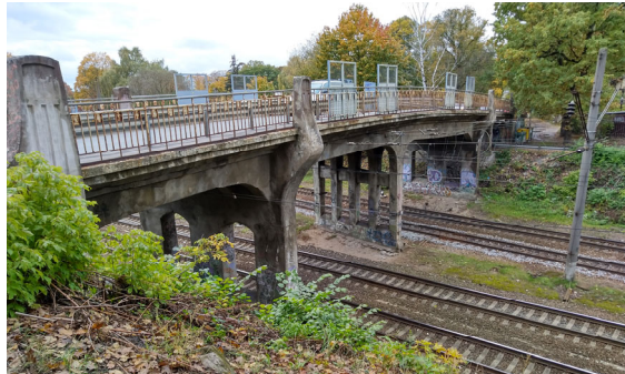
Torņakalna ielas pārvads
